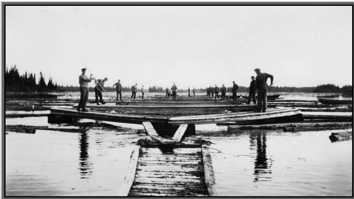
Arbetare sorterar virke på det äldre sorteringsverket (eller skiljet) vid Bjästeruddens sydspets i Sävarån i Skeppsvik. Foto: Okänd, 1920-30 talet.
