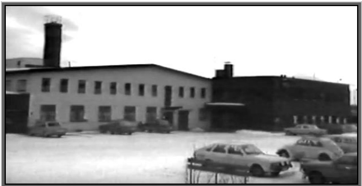
Lokalerna på Gimonäs som övertagits av Umeå Gjuteri och utvidgats med byggnaden till höger.
