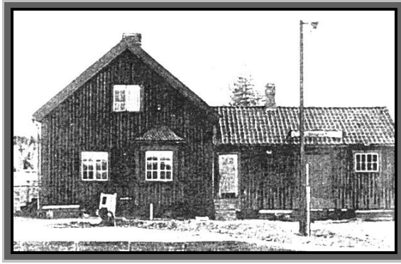
Lastplats och hållplats med väntsal i Gimonäs fyra kilometer från stationen i Umeå. Huset rivs omkring 1965.
