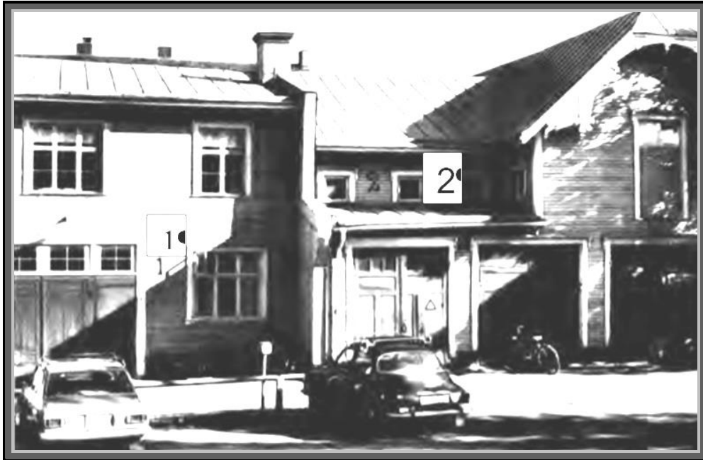
I brandstationens vaktrum (1) finns den första sändaren i Umeå 1925-1929. Sedan brandkåren motiverats blir foderrummet på vinden (2) ledigt och inreds till lokaler för radioklubbens verksamhet 1930-1935. Brandstationen ligger då i Moritzska gårdens gårdshus i kvarteret Idun. Foto i Västerbottens museum.
