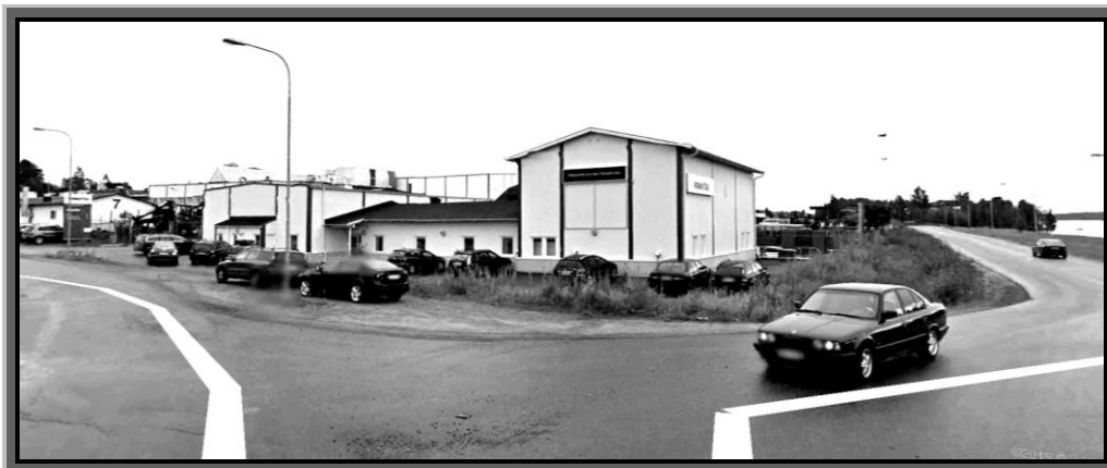
Byggnaden strax söder om Strömpilplatsen där företaget hade sin verksamhet
