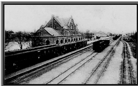
Umeå stationsområdet fotograferat från viadukten mellan staden och Haga.
