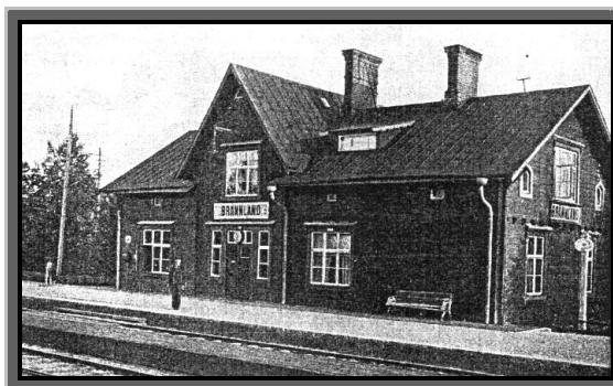
Brännlands station 13 km från stationen i Umeå.
