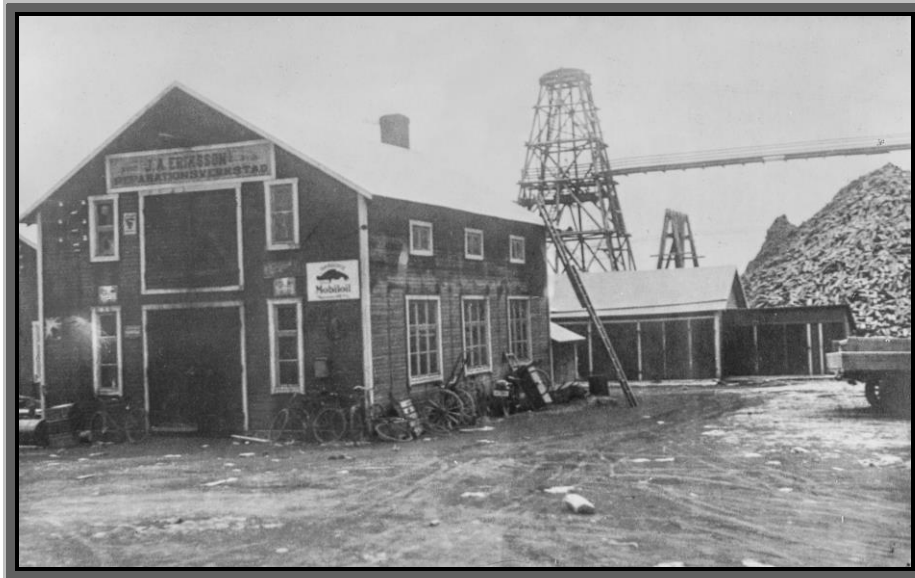
Gjuteriet och verkstaden
